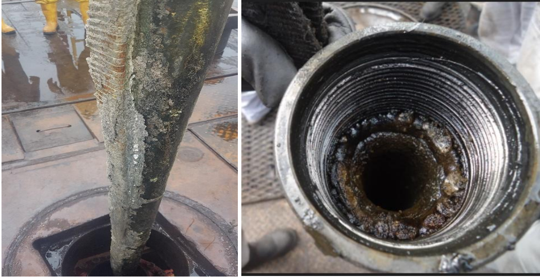
Ilustración 15. Acumulación de escala en cable eléctrico del equipo BES y diámetro interno de la tubería de producción
