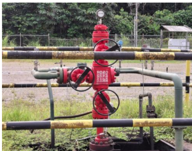
Ilustración 12. Cabezal de producción pozo SHSI-119
