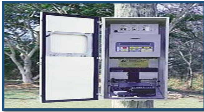
Figura 65: Seccionador tensión- tiempo : Diego Alejandro Muñoz Restrepo - Hamilton Johns Alvarez
