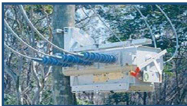
Figura 64: Seccionador automático : Diego Alejandro Muñoz Restrepo - Hamilton Johns Alvarez
