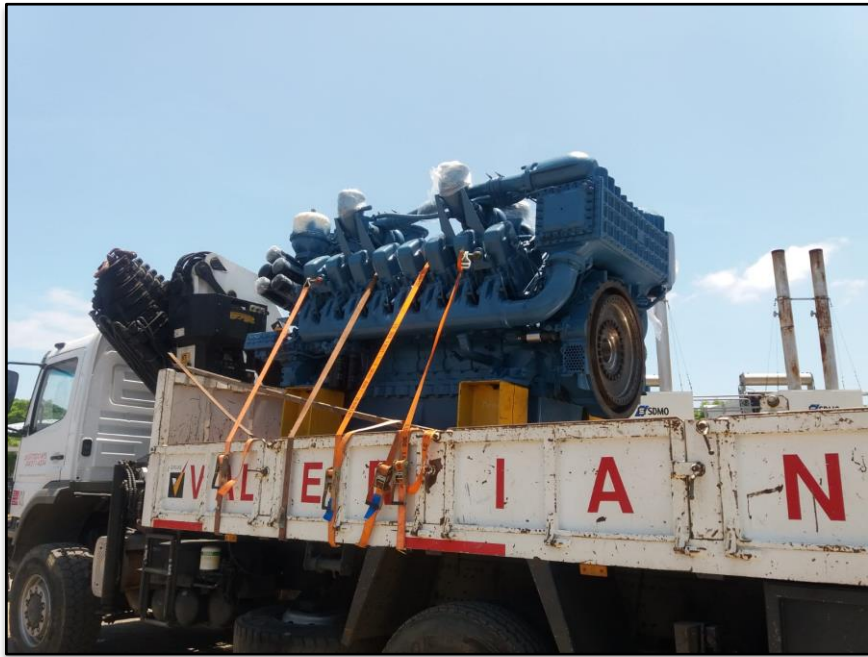
Momento de llegada de los 5 generadores a la Refinería La Libertad.
