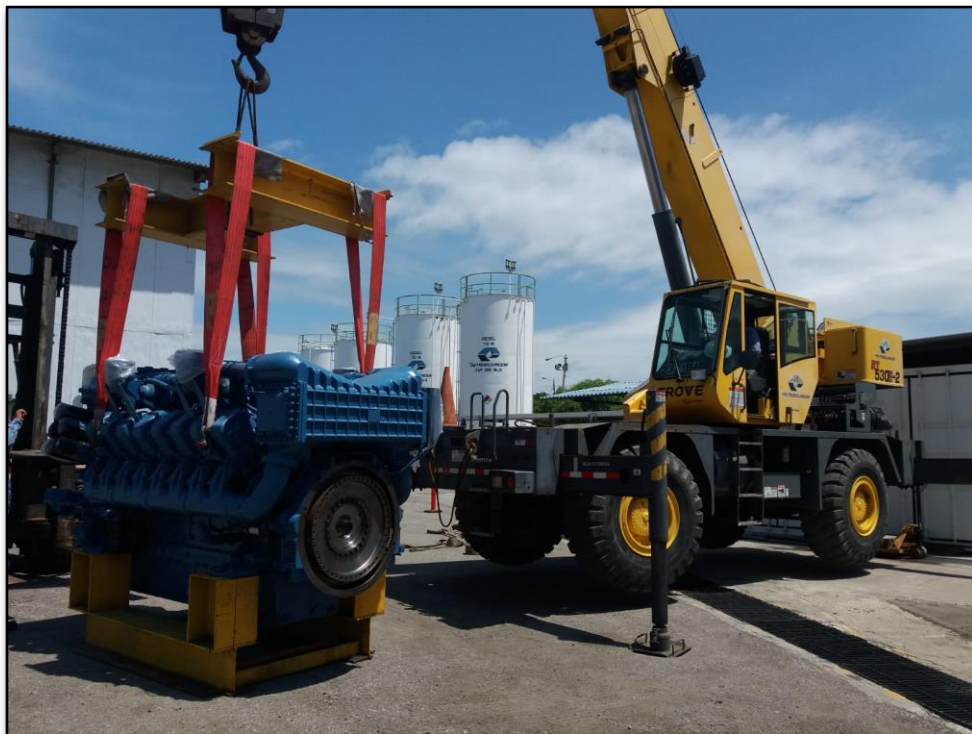
Instalación de los generadores en la Refinería La Libertad.
