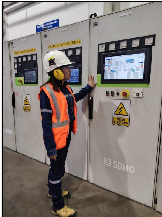
En otra área de las instalaciones de la Refinería La Libertad, constatando la diversidad de actividades.
