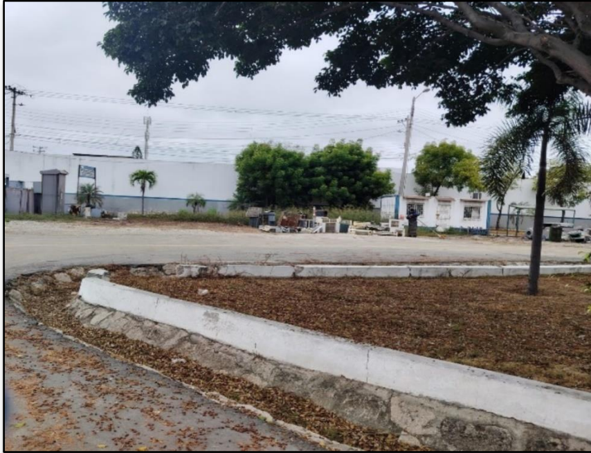
Instalaciones de la Refinería La Libertad, que serviría de base para las torres de paneles fotovoltaicos.
