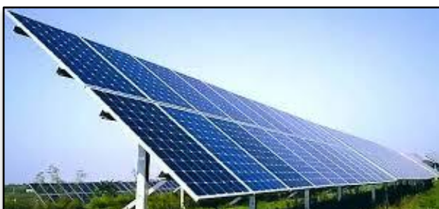
Paneles solares policristalinos.
