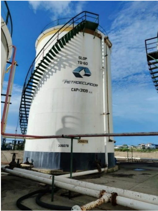
Figura 5: Tanque de Slop #60
