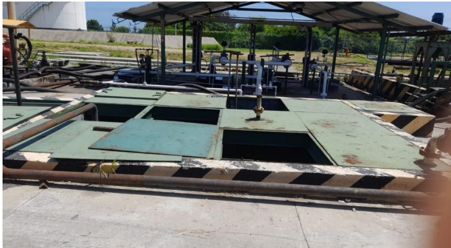
Figura 18: Separador API #3-CPI
