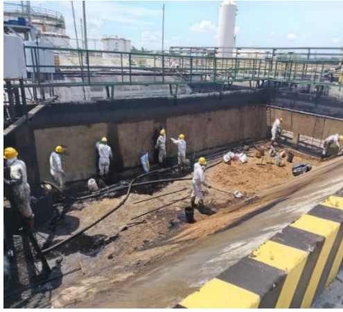
Figura 25: Colocación de aserrín para sacar sedimentos en API #1
