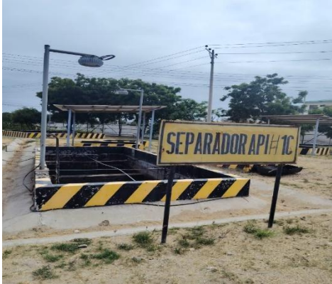
Figura 13: Mini Separadores API-1C
