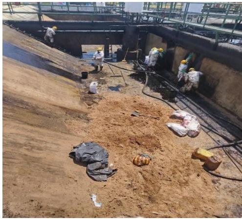
Figura 26: Retiro de sedimentos en API #1
