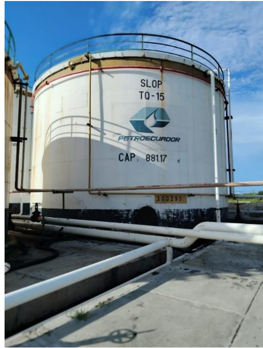
Figura 7: Tanque de Slop #15
