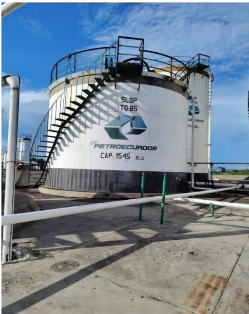
Figura 6: Tanque de Slop #85
