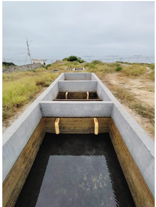
Figura 23: Mini separadores API #3
