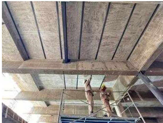
Figura 3. Imagen ilustrativa sobre corrosión en estructuras metálicas.
