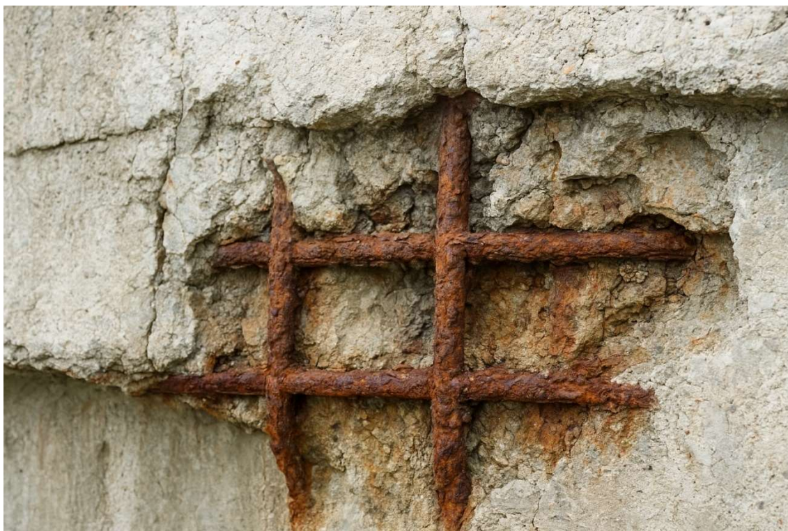
Figura 2 Imagen ilustrativa sobre el proceso de corrosión.
