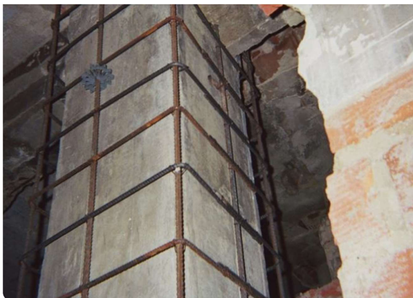
Figura 4. Disposición de barras de espera en arranque del pilar.
