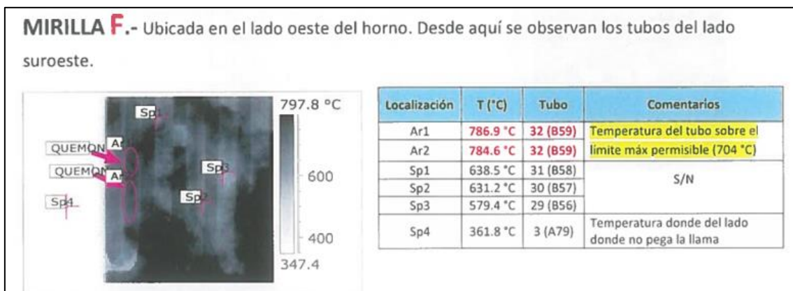
Figura 23. Temperaturas máximas en el serpentín lado SO.
