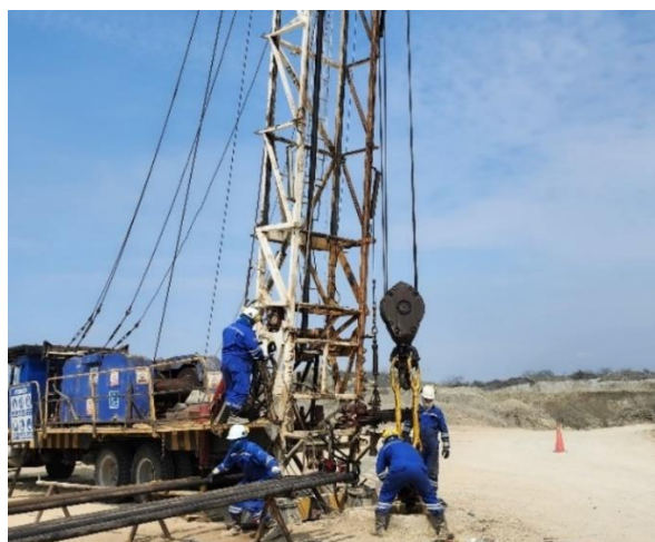
Figura. 14 Equipo U233 realizando pulling a pozo ANCI230 con parafina
