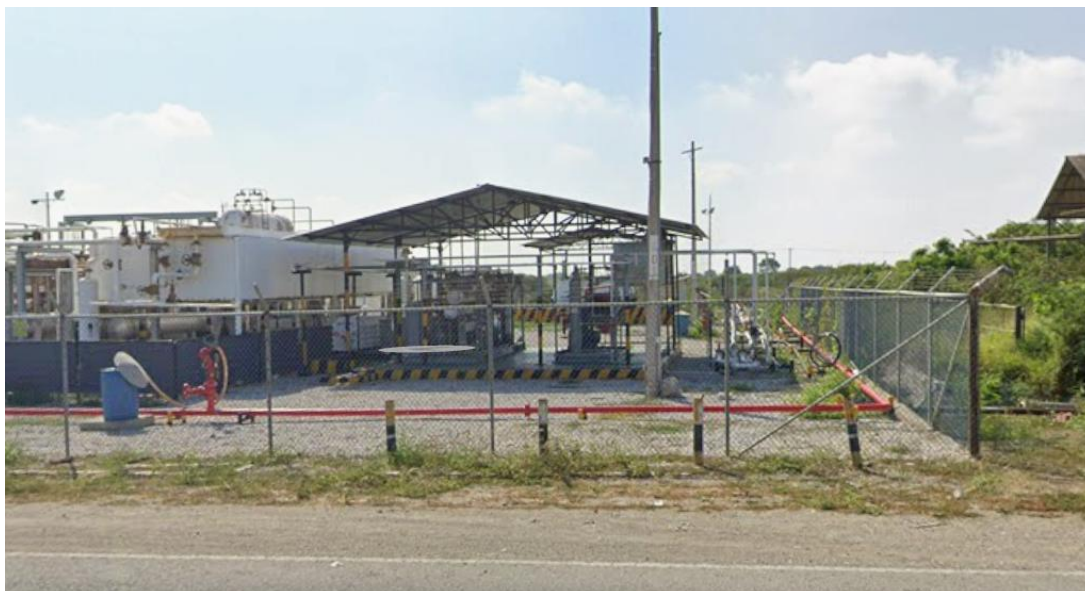
Figura 19 Planta de gasolina Pacifpetrol S.A
