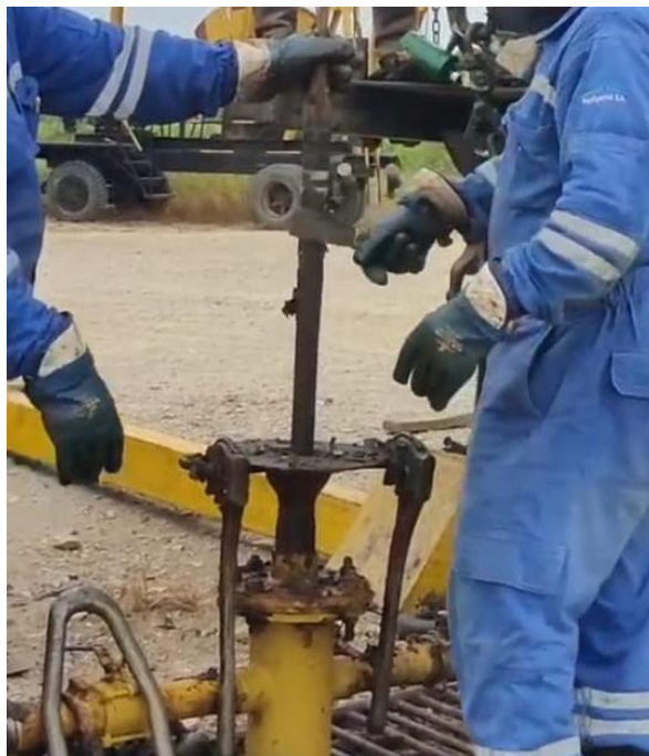
Figura 40 Recolección de muestra de parafina durante el Pulling del pozo ANC0024
