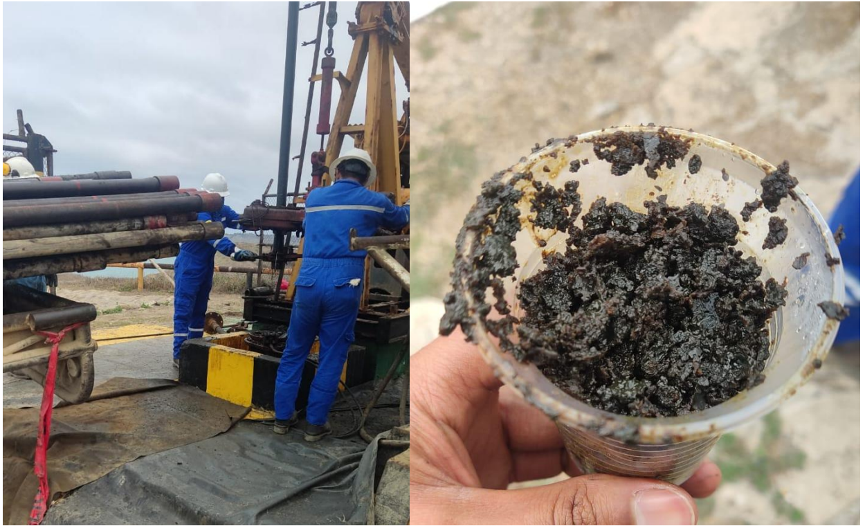
Figura 39 Recolección de muestra de parafina durante el Pulling del pozo ANC0093
