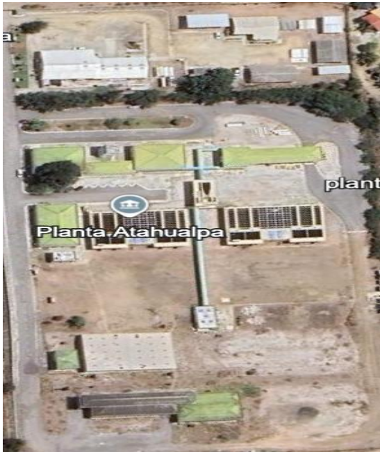
Figura 7. Ubicación de la planta potabilizadora.
