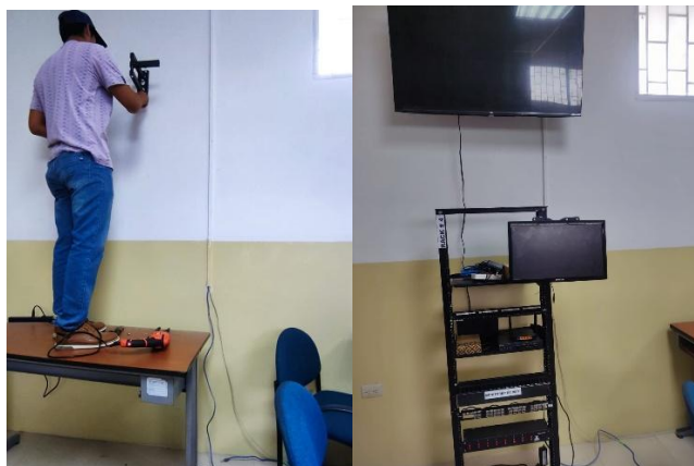
Figura 21 Instalación de pantalla y equipo Mikrotik al RAD
