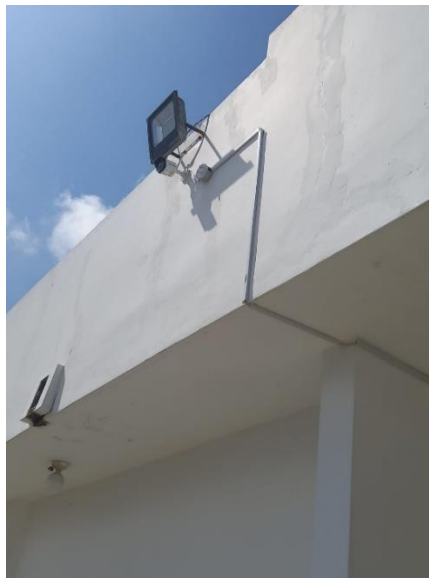
Figura 17 - Ubicación de la cámara
