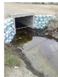
D y E) Entrada y salida - ducto cajón.
