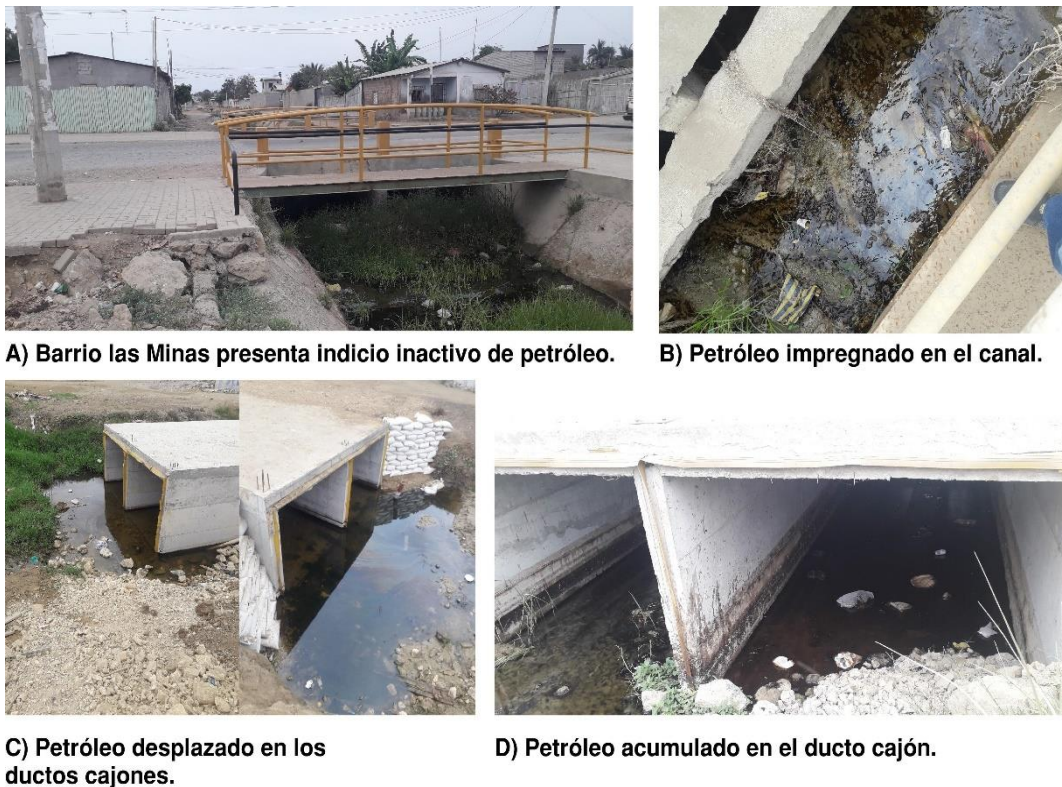
Figura 42. Detalles Fotográficos del indicio inactivo en barrio Las Minas.
