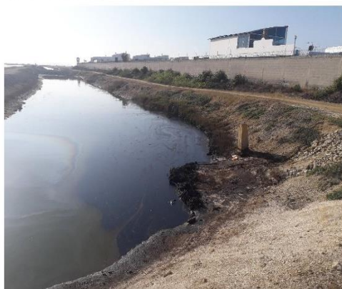
D) Acumulación en esquina del canal.
