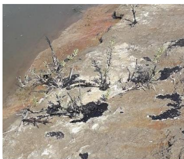
A) Surgencia en paredes del canal.
