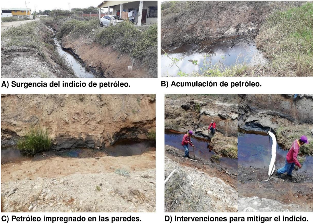
Figura 45. Fotografías del indicio activo de petróleo en canal Costa de Oro.
