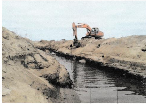
Figura 5. Excavación de zanjas.
