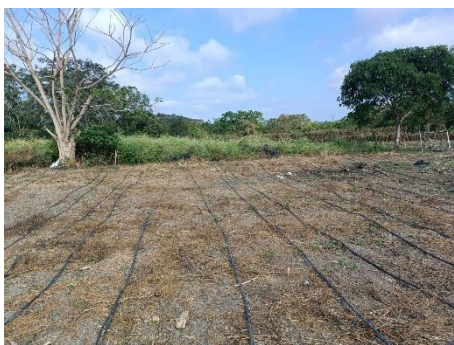
Figura 7A. Instalación del sistema de riego por goteo.
