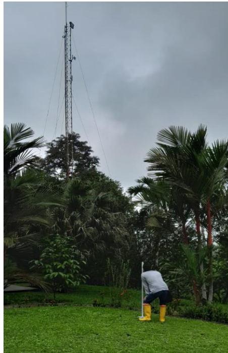
Figura 3. 1: Torre metálica de telecomunicaciones en la sede administrativa de Protropic Cía. Ltda.
