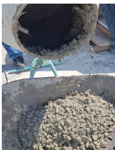
(a) Hormigón reforzado con fibra, (b) Adición de fibra.
