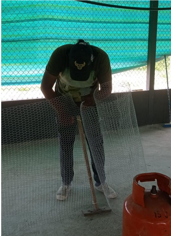
Figura 1A. Adecuación del galpón
