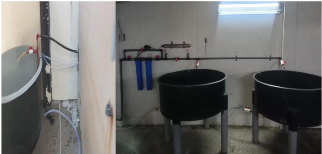
Figura 12. Instalación del sistema de depuración
