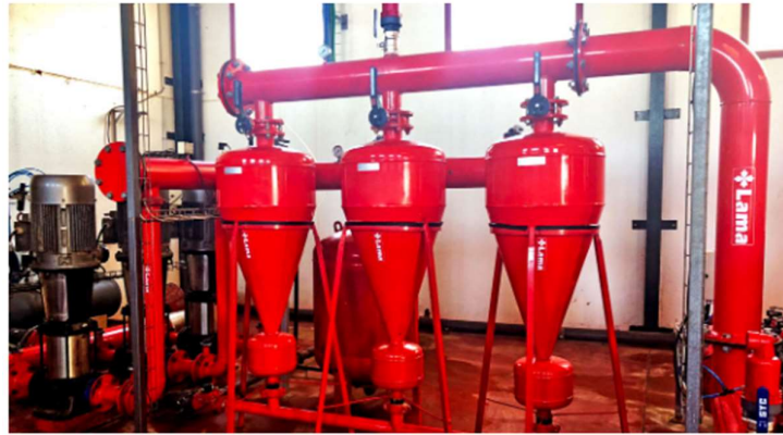
Figura 4: Hidrociclones; Fuente (Iagua;2020)
