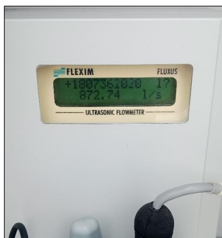
Caudalímetro de entrada a la Planta Potabilizadora Atahualpa.
