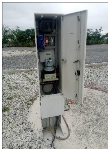
Caudalímetro de entrada a la Planta Potabilizadora Atahualpa.
