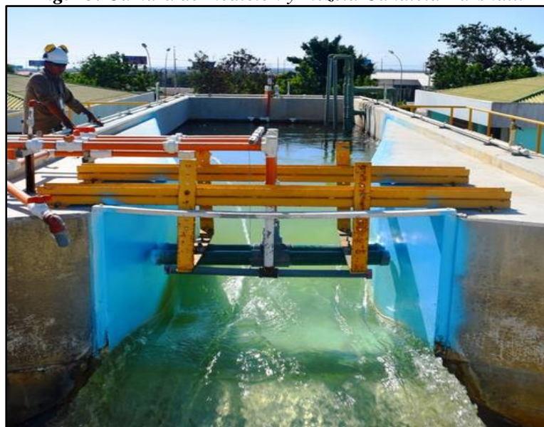
Fig. 15. Cámara de medición y mezcla Canaleta Parshall.
