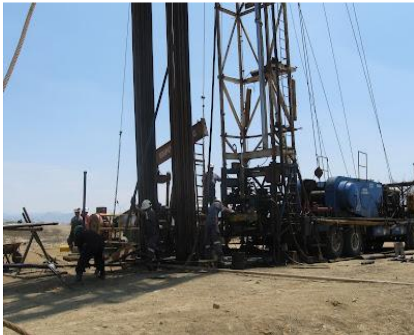
Figura 44. Unidad de Pulling operando. PETROBLOGGER.COM. https://www.ingenieriadepetroleo.com/pulling-de-pozos-petroleros/
