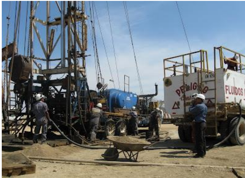
Figura 43. Unidad de Pulling en campo petrolero. PETROBLOGGER.COM. https://www.ingenieriadepetroleo.com/pulling-de-pozos-petroleros/
