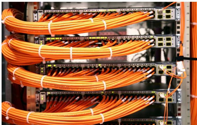
*Figura 10: Cableado Horizontal*
