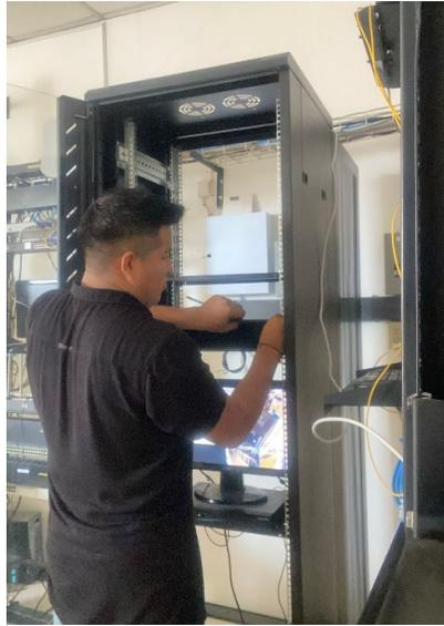
*Figura 26: Ubicación de Bandejas para equipos a colocar*
