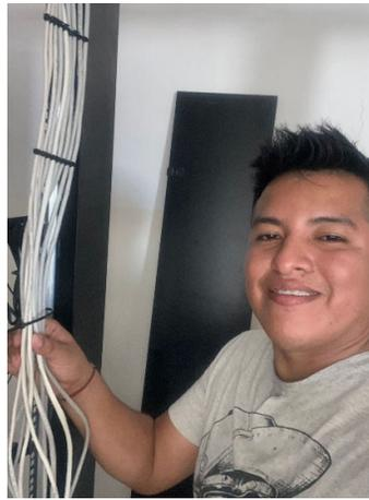
*Figura 28: Proceso de Peinado de Cableado de Red.*
