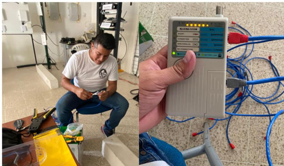
*Figura 27: Proceso de Ponchado y Test de Cables UTP*
