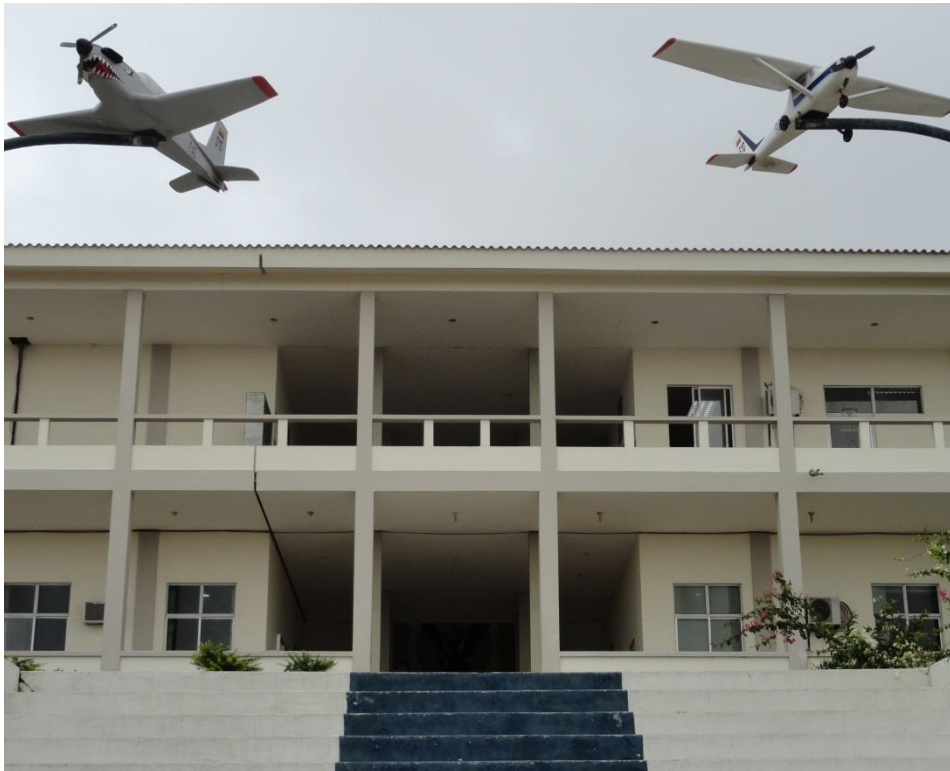
EDIFICIO DEL COMANDO -SECCION DEL TALENTO HUMANO
