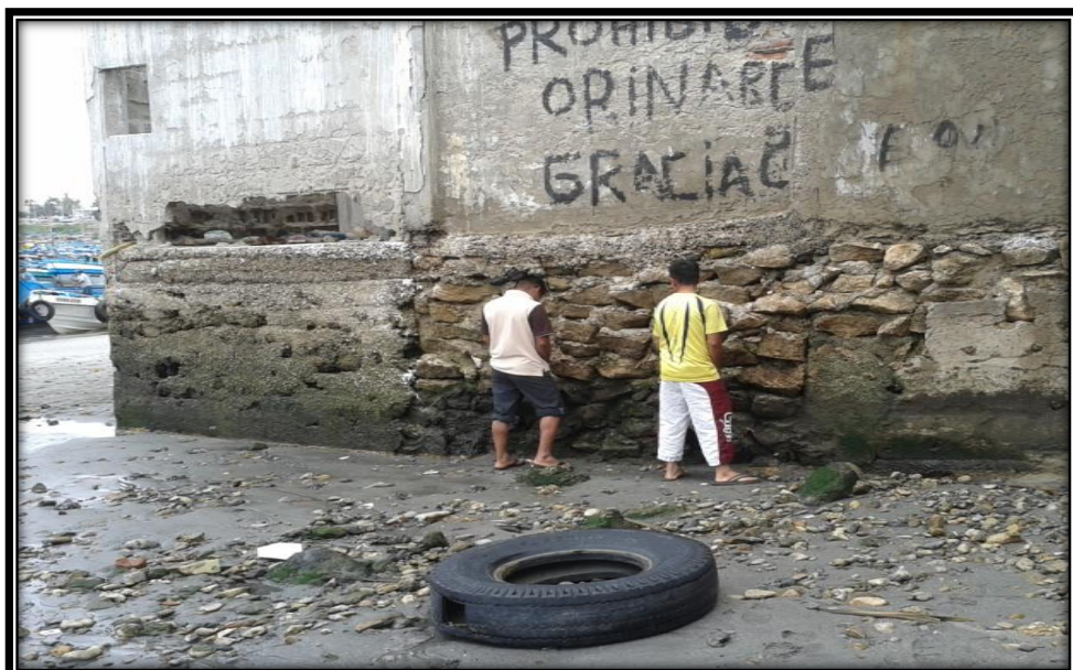
Contaminación del agua a través de la filtración de urinarios Fuente: Johanna Ramírez Liriano.
