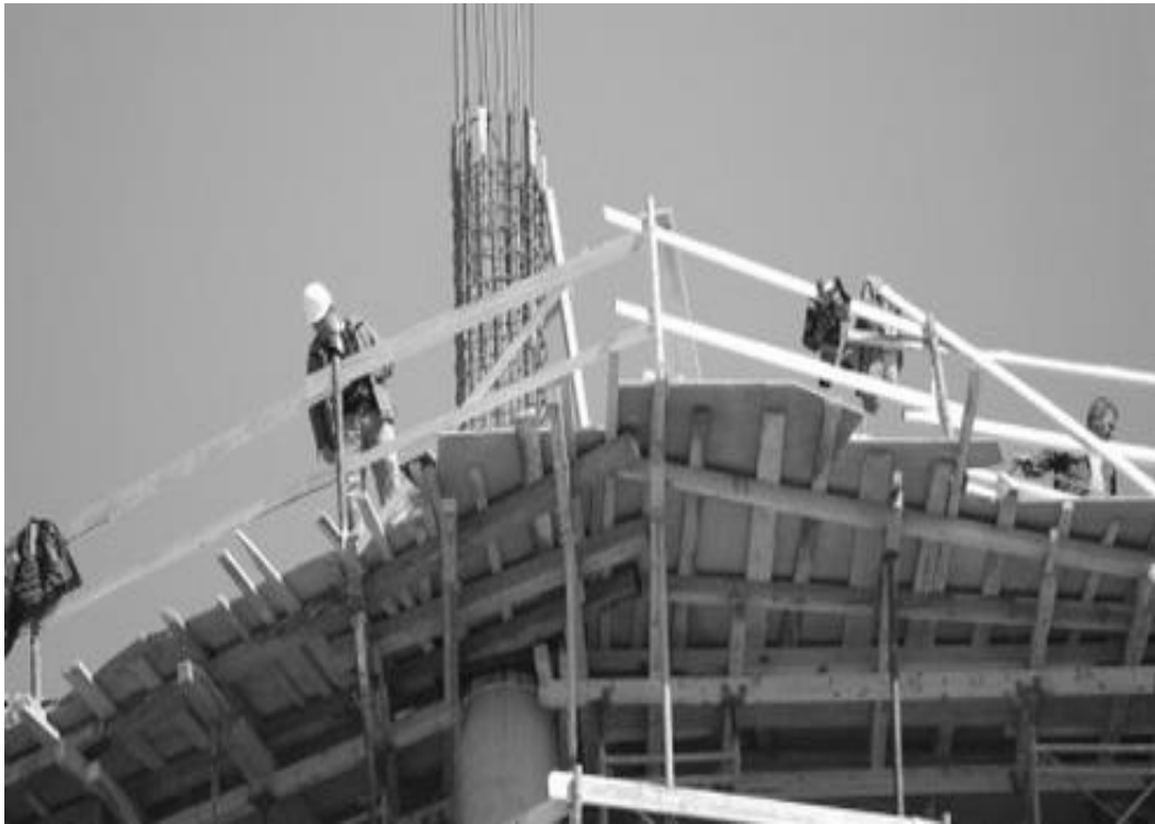
Operarios trabajando la losa de una vivienda
