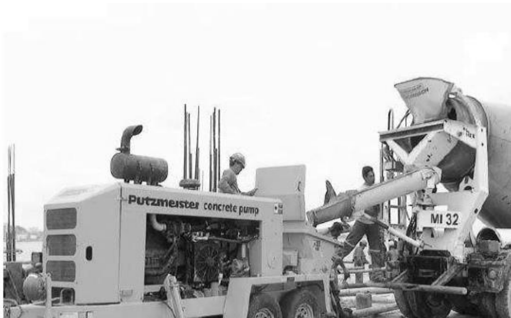
Operarios en obras durante el primer año de actividad, con maquinaria de alquiler
