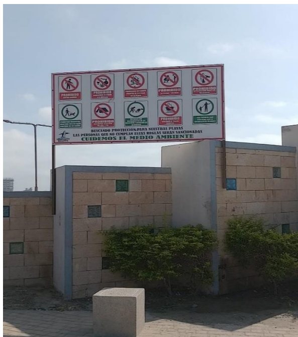
Figura 13: Evidencia de señalización informativa
