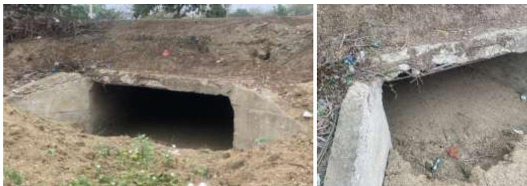
*Nota.* Tiene un ancho de 3.20 m., altura de 1.25 m y una longitud de 14.50 m., a pesar de que cumple con las normativas del MTOP, su condición actual no es la adecuada pues presenta maleza, erosión en el suelo y corrosión en las varillas debido a su exposición a la intemperie.
