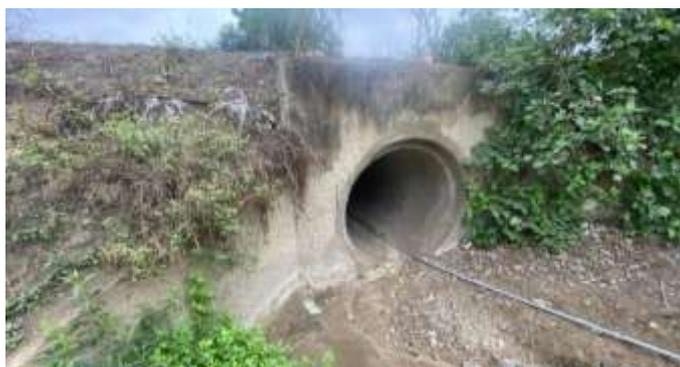
Las cuatro alcantarillas circulares de hormigón presentan un diámetro de 0.90 m. La alcantarilla de la abscisa 0+800 tiene una longitud de 14.50 m., mientras que las restantes (abscisas: 1+440; 2+770; 4+280) poseen en su diseño una longitud de 11.20 m.
