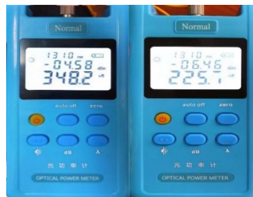
Figura 73. Potencia del tercer enlace de fibra óptica.
