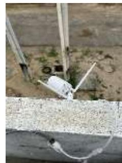
*Ilustración 352. Instalación de cámara con medio de transmisión de cable UTP.*
