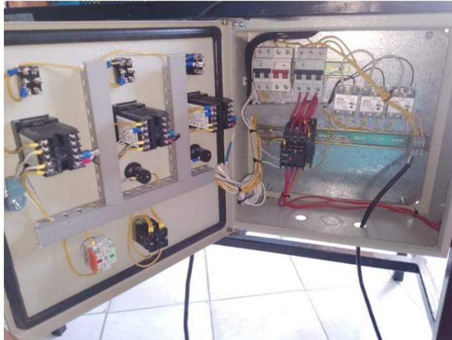
Nota. Conexiones eléctricas de la extrusora
