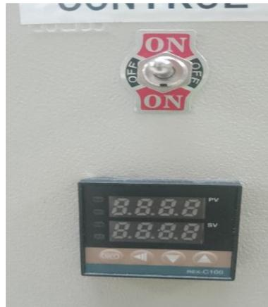
Nota. Sistema de encendido, apagado de las resistencia y control de temperatura
