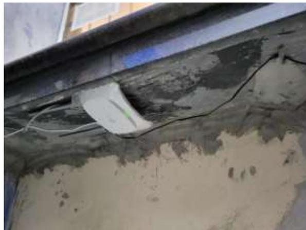
*Ilustración 29 - Puntos de acceso ubicados de manera incorrecta.*
