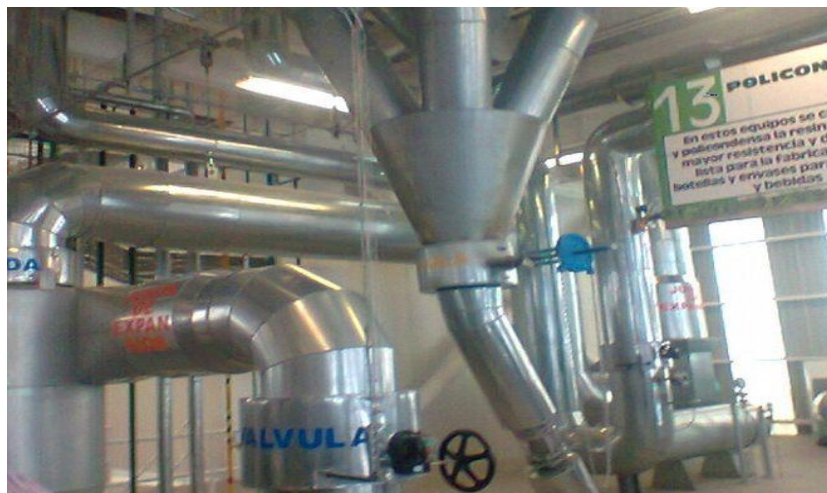
Figura # 14 maquinaria de proceso de resina
