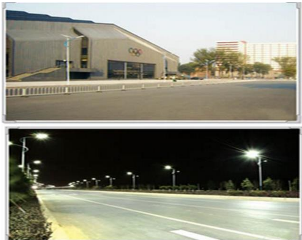
FIGURA 11 Equipos e Instalaciones
