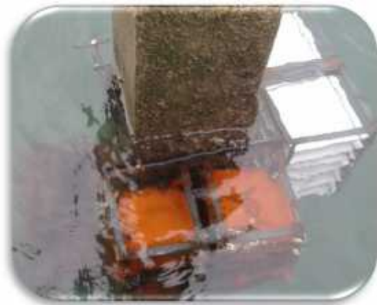
Foto 2: Estructuras sumergidas en bajamar sobre los pilares de cada sector.
