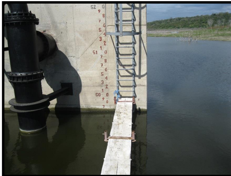
Foto 6. Estación 3 - Torre de medición
