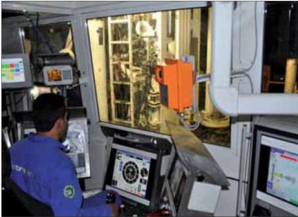
Cabina de perforación del RIG HH220
