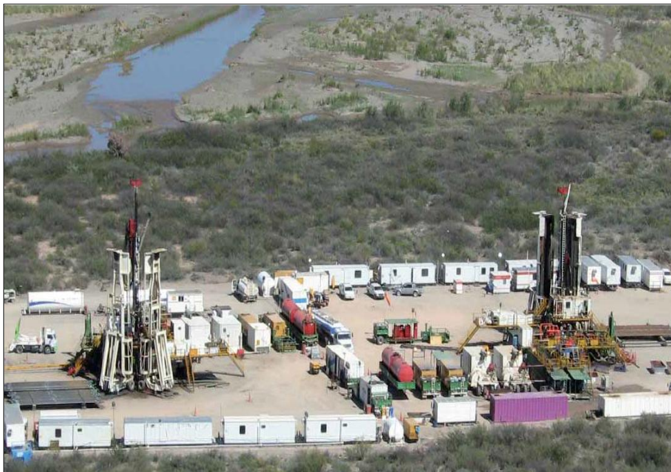
HH102 en el sitio de la perforación
