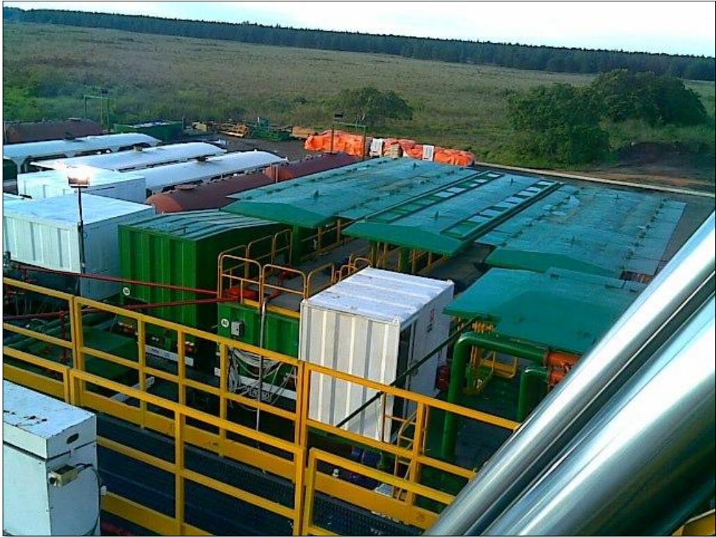
Tanques de lodo
