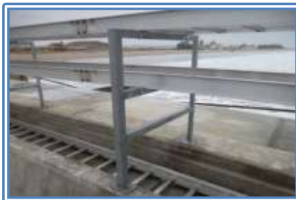
Figura 11. Durmientes para líneas de control (Eléctricos), Fuente: FLOPEC.
