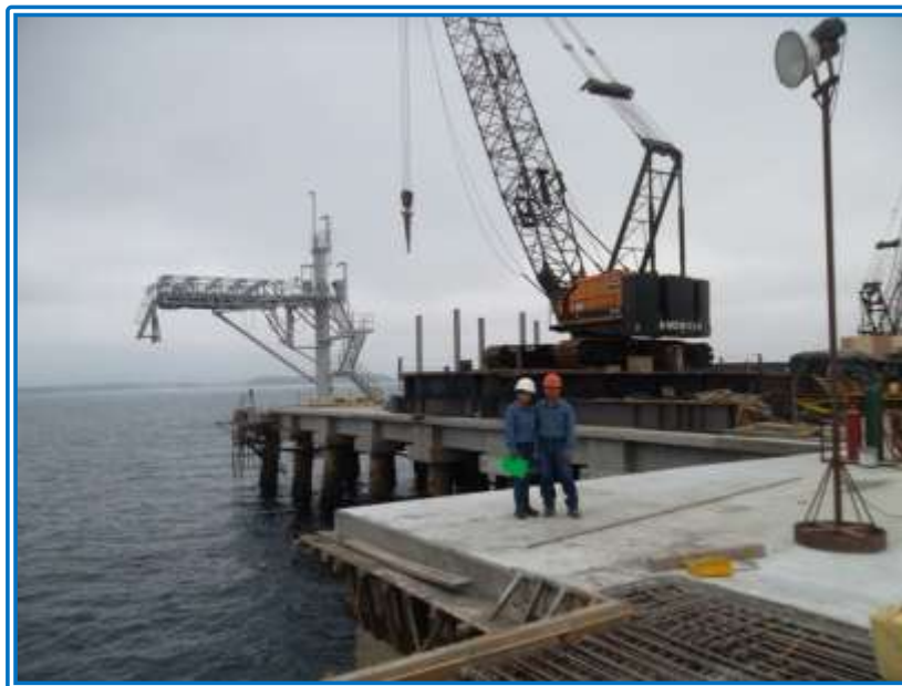
ANEXO F8. TESISTAS EN AREA DE MUELLE.
