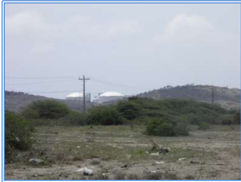
ANEXO F3. DESNIVEL DE ELEVACIONES; DESDE LA POBLACIÓN DE MONTEVERDE SE APRECIA PARTE DE LOS TANQUES DE PROPANO VISTO DESDE LA POBLACION DE MONTEVERDE
