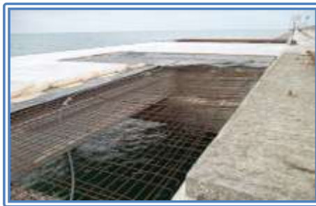
Figura 9: Imagen inferior, base en construcción.
