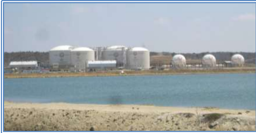
Figura 28: Entrante de agua desde el mar hacia las piscinas de Ecuasal
