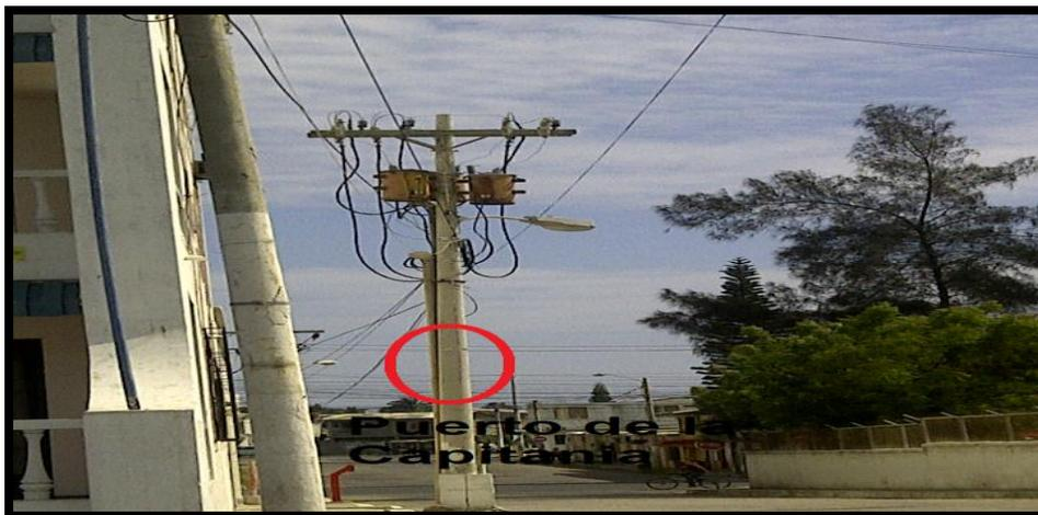
La representación en la figura 4.3 demuestra que en los puntos medidos hay una igualdad de campo magnético, donde la media es 0.1, en la figura 4.4 muestra el punto 11 que se detalla los 0.1  $\mu\text{T}$  encontrados en todo el perímetro de estas segundas mediciones.
