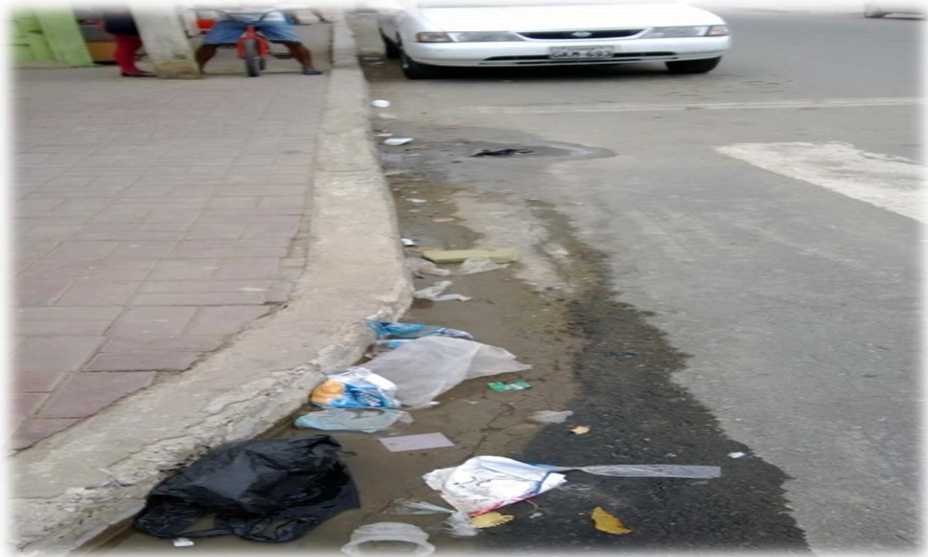
ANEXO N° 26 Alcantarillados con Basura
