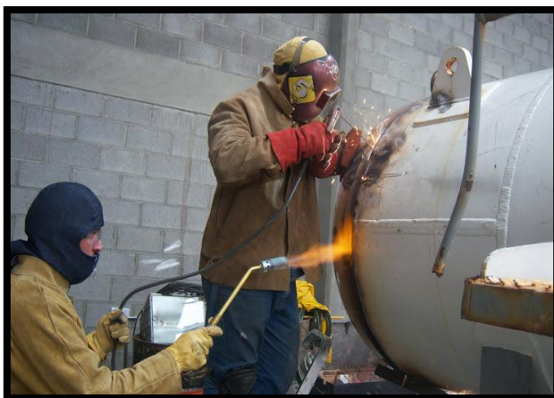
Figura N°10: Reparación del separador trifásico de 44" de diámetro x 2" de espesor, serie 600 Fuente: Andes Petroleum.
