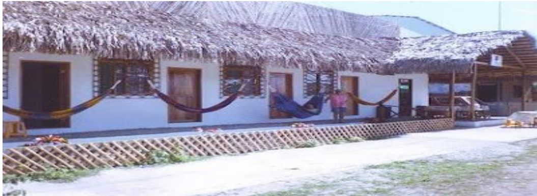
Fuente: Fachada frontal del modelo de la cabaña comunitaria Elaborado por: Silvia Cedeño Zambrano
