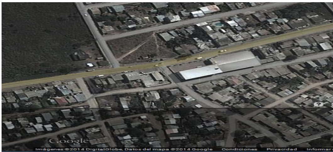
FIGURA 8. Predio donde se ubicará la sucursal del almacén "Comercial Juanita".
