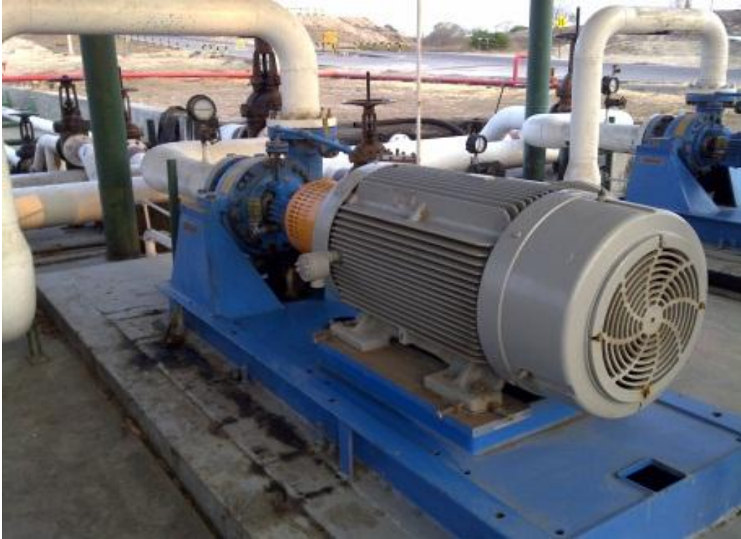
Figura 40. Motor de la bomba estación # 3 Fuente: Fotografía Refinería La Libertad Elaboración: Propia
