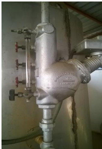
Figura N° 3 Control tipo flotador
