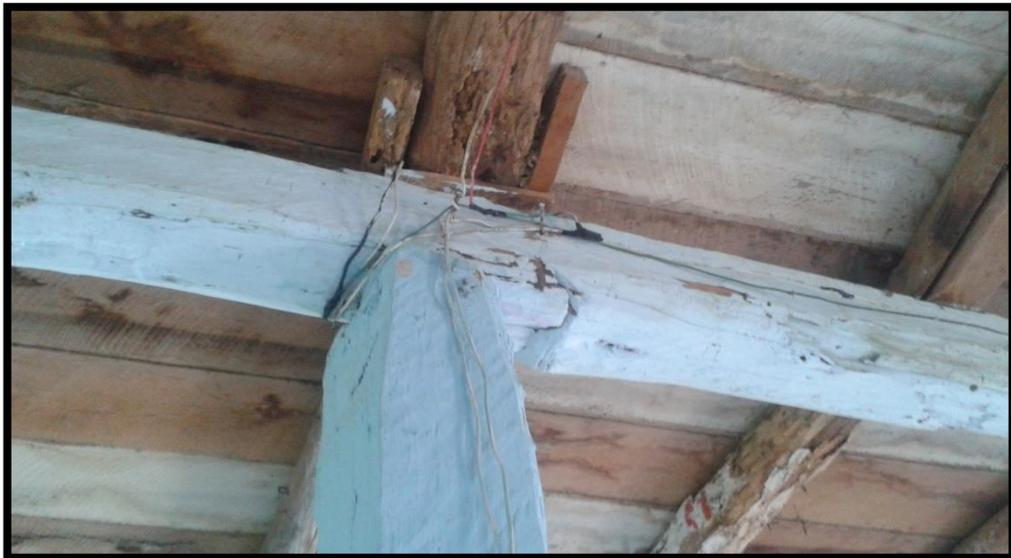
Cableado deteriorado, representando un alto riesgo de corto circuito
