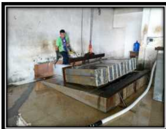
Imagen n° 9 Descarga de las marquetas.
