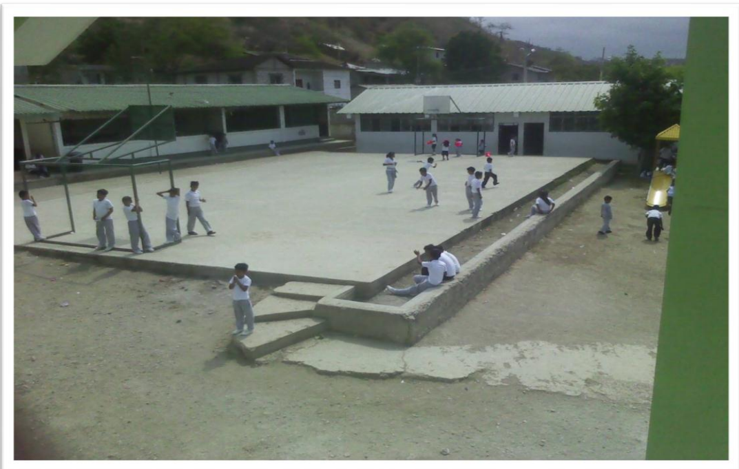
Foto N°.2 Instalaciones de la Escuela de Educación Básica “Luis Eduardo Rosales Santos”
