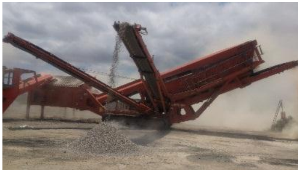
Figura 2. 3 Cribado. Fuente: V. Hidalgo, A. Rodríguez.
