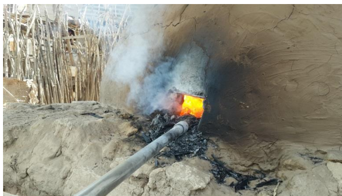
Ilustración 3.7: Quemador actuando como regulador de temperatura.
