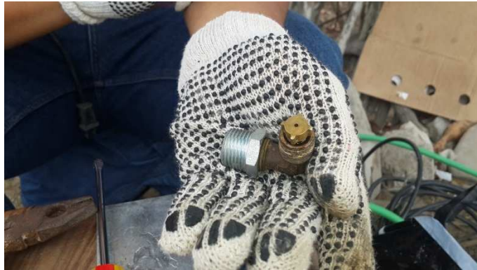
Ilustración 8.2: Ensamblado de piezas para quemador, instalación del pico para gas.
