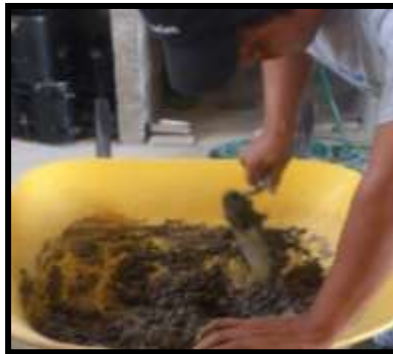
Figura 15. Preparación de Hormigón liviano con Arcilla Expandida Fuente: D. Yagual – D. Villacís
